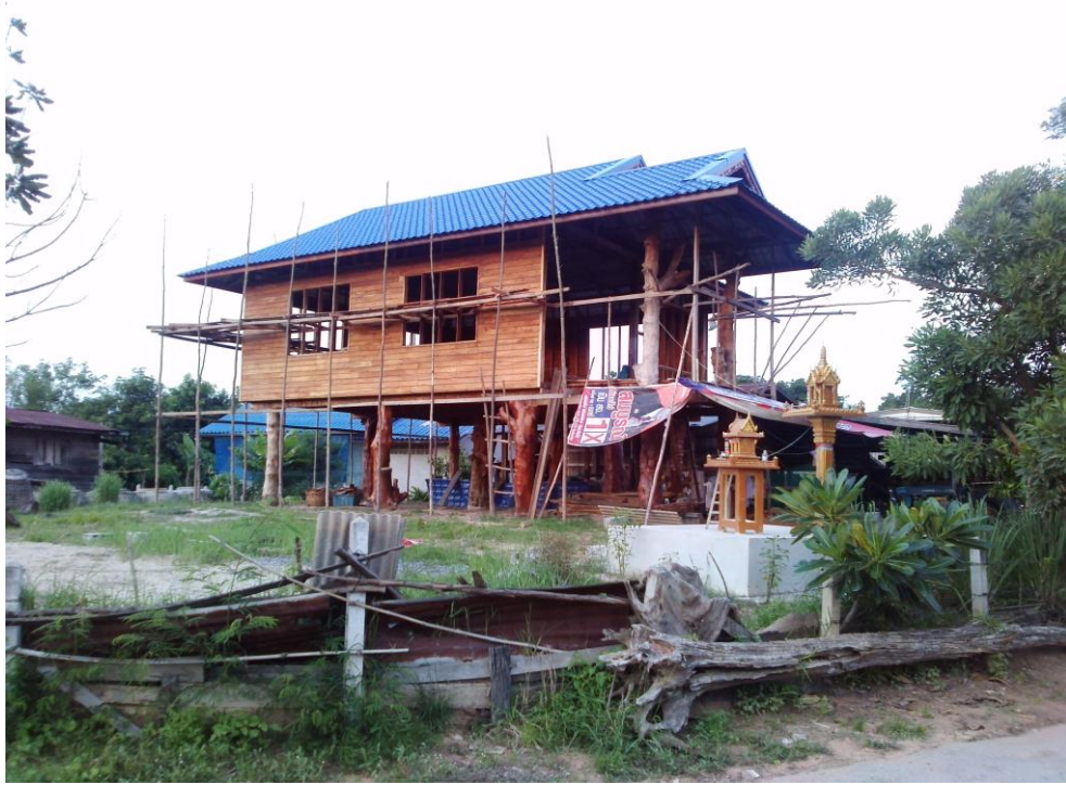
รูปที่ 1.2 อาคารพักอาศัยที่กำลังก่อสร้างในเขตตำบลโบสถ์
